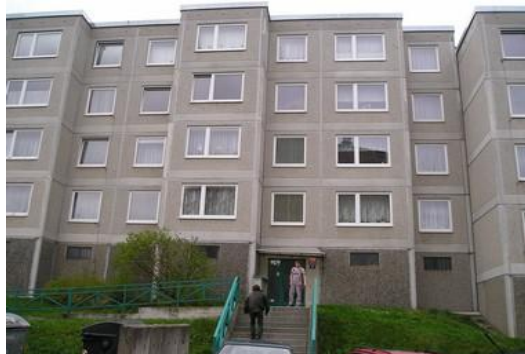
F1 Uliční pohled na budovu
